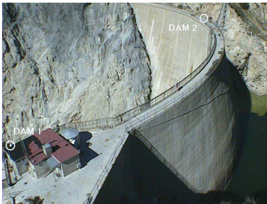
Figura 5 – Pacoima Dam: Stazioni GPS per monitoraggio in continuo ( foto by J. Galetzka )
